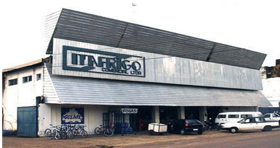
Figura 3: Vista externa do Supermercado Itafrigo Fonte: (ROCHA, 2012)
