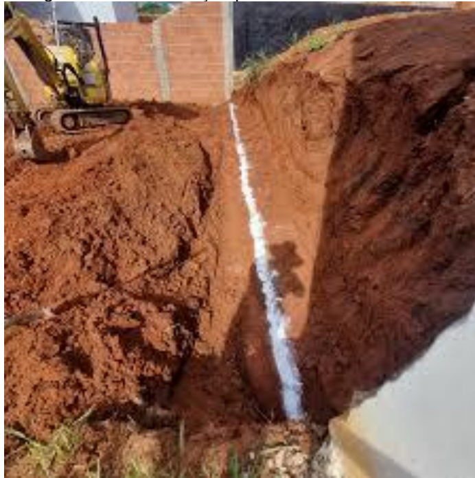
Figura 13 – Demarcação para levantamento do Muro
