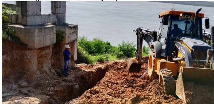
Figura 14 – Escavação para o início da obra
