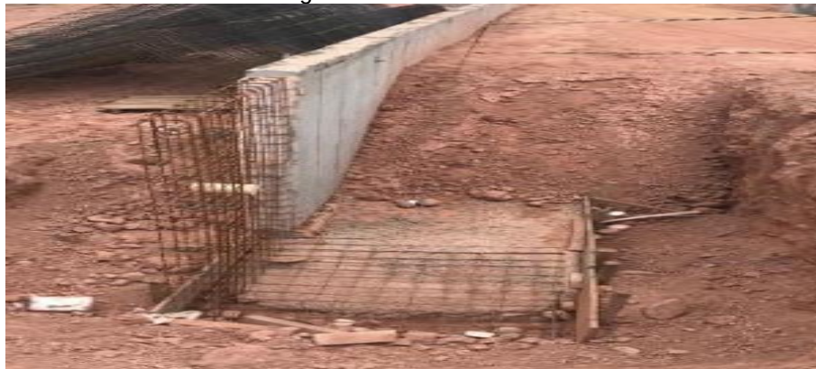
Figura 2 - Muro de flexão
