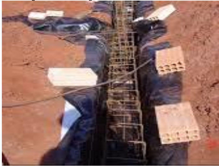
Figura 15 – Ferragem e Revestimento com lona
