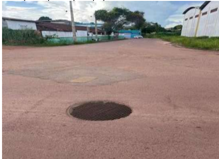
Figura 16 – Identificação da presença de poço de visita: 2° Rua da Liberdade PV nº 2.
