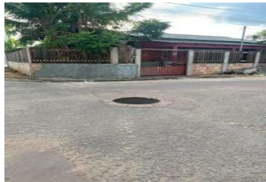
35ª Figura. 4ª Rua com 7ª Travessa da Liberdade - PV nº 8. 4,27601° S, 55,99608° O
