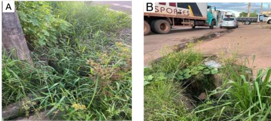
Figura 21 – Inspeção técnica na 4 a Rua da Liberdade: análise das BLs nº 27 e 28.
