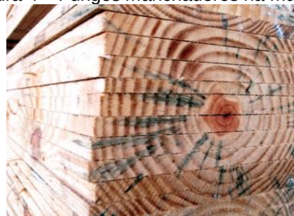
Figura 4 – Fungos manchadores na madeira
