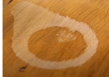
Figura 16 – Mancha de água na madeira
