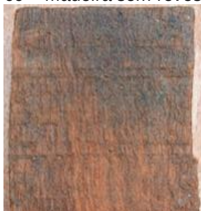
Figura 69 – Madeira sem revestimento
