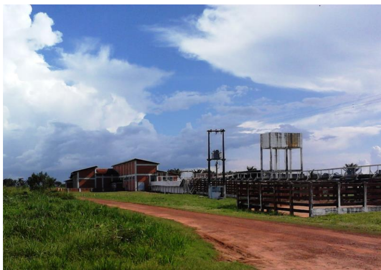
Figura 6: Foto do frigorífico FRIVATA. Fonte: Autora do TCC, 2012
