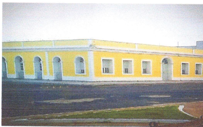
Figura 6: Paço Municipal (Itaituba - Pará, 2017) Fonte: Arquivo pessoal do autor.
