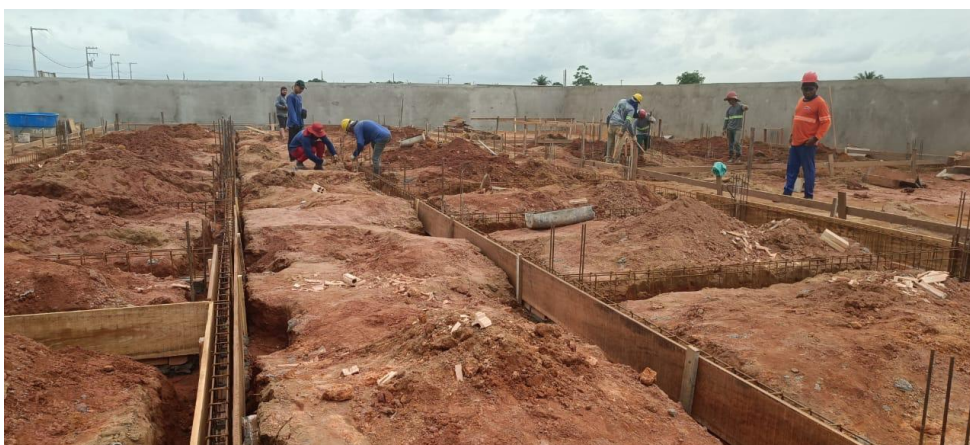
Figura 5 – Escavação de vigas, baldrame e forma. Fonte: Autoria Própria (2024)
