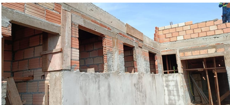
Figura 6 – Execução de alvenaria. Fonte: Autoria Própria (2024)
