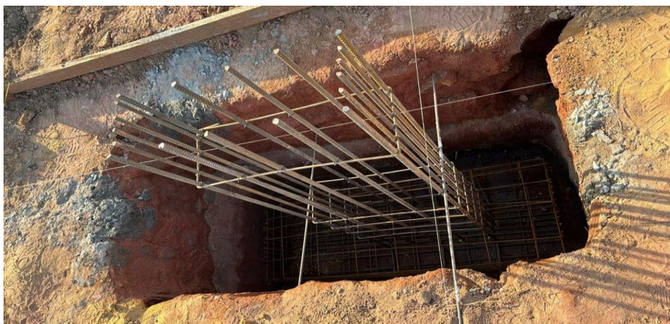
Figura 4 – Locação de fundação e arranque dos pilares. Fonte: Autoria Própria (2024)
