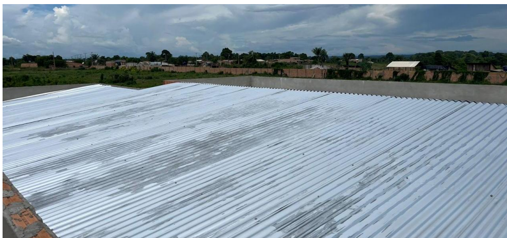
Figura 11 – Execução de telhado em estrutura metálica. Fonte: Autoria Própria (2024)
