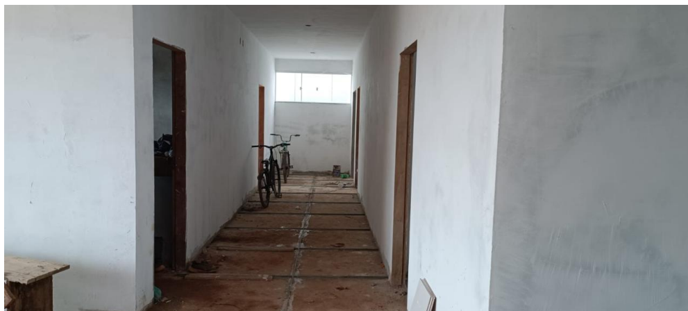
Figura 13 – Dilatação do piso. Fonte: Autoria Própria (2024)
