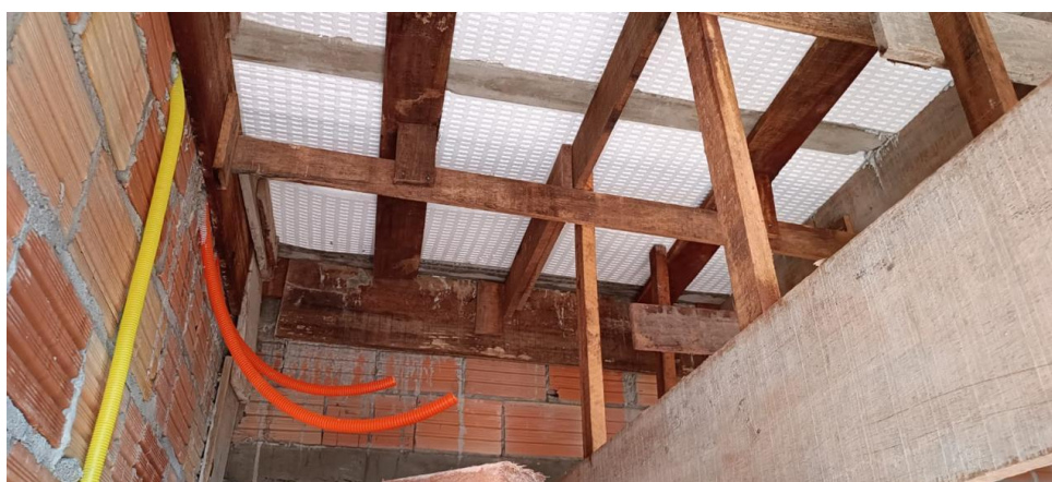
Figura 9 – Execução de laje. Fonte: Autoria Própria (2024)
