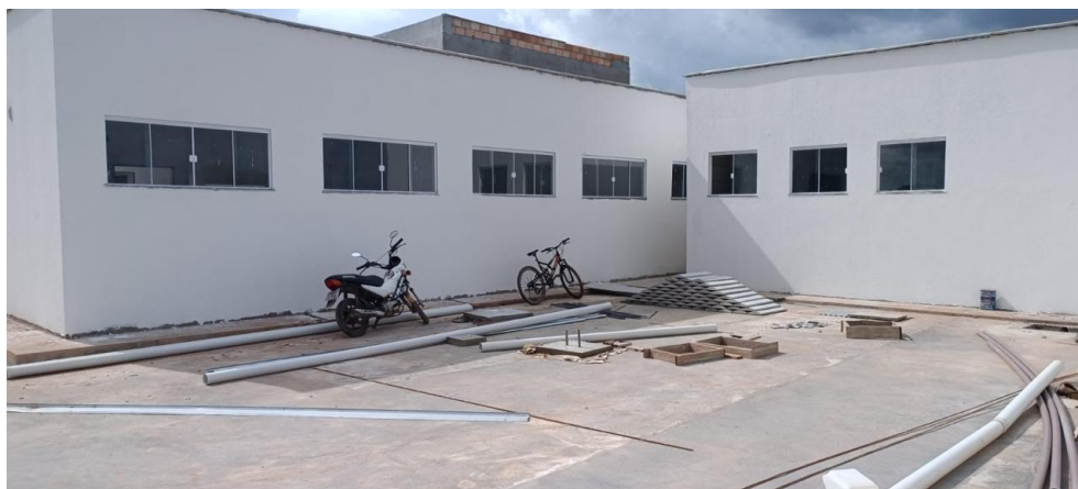
Figura 12 – Pintura externa e instalação de esquadrias de vidro. Fonte: Autoria Própria (2024)
