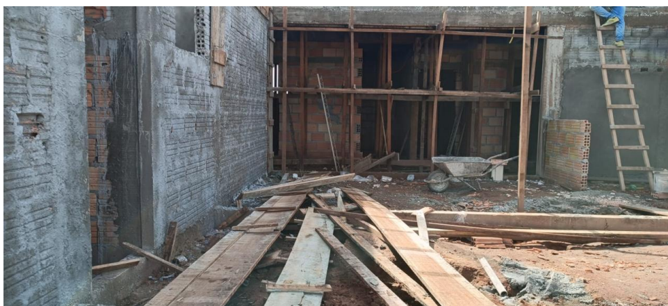
Figura 7 – Chapisco. Fonte: Autoria Própria (2024)
