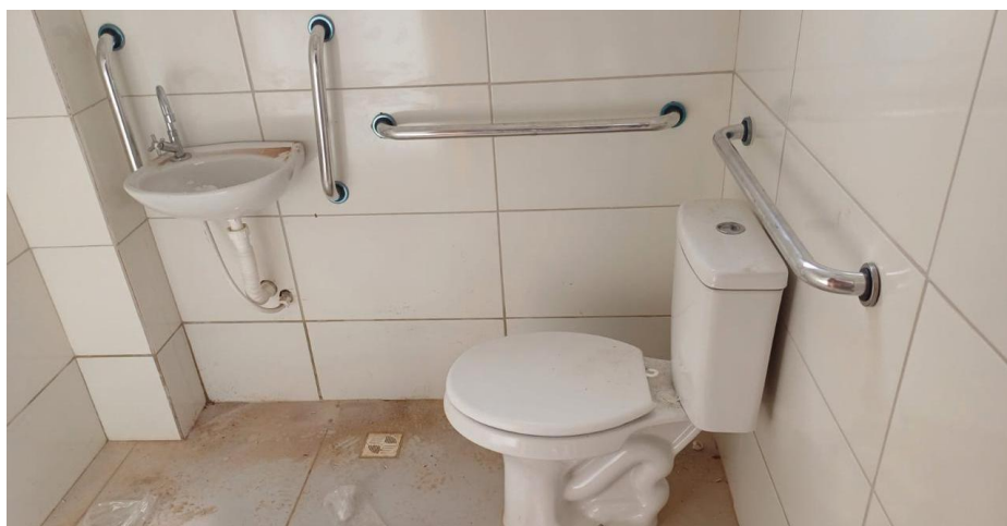
Figura 16 – Banheiro PCD. Fonte: Autoria Própria (2024)
