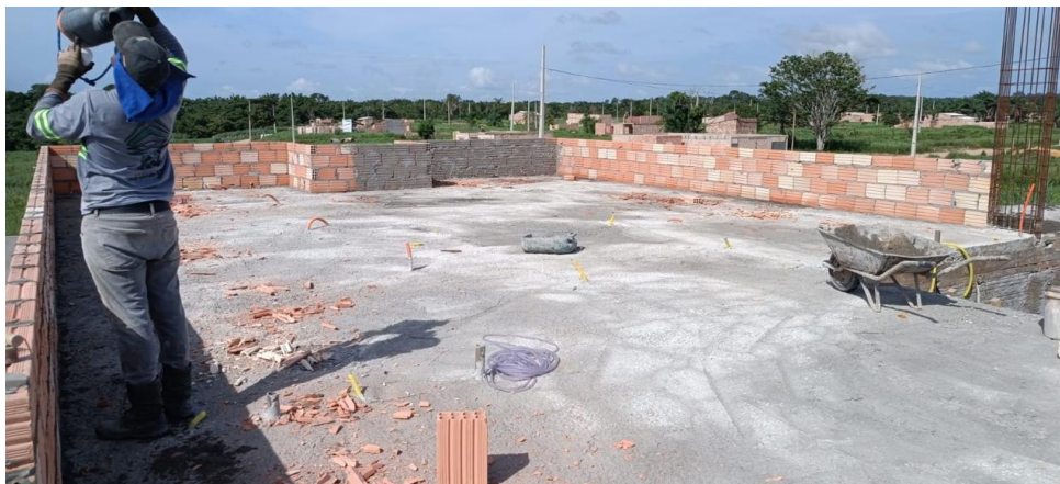
Figura 10 – Execução de platibanda. Fonte: Autoria Própria (2024)
