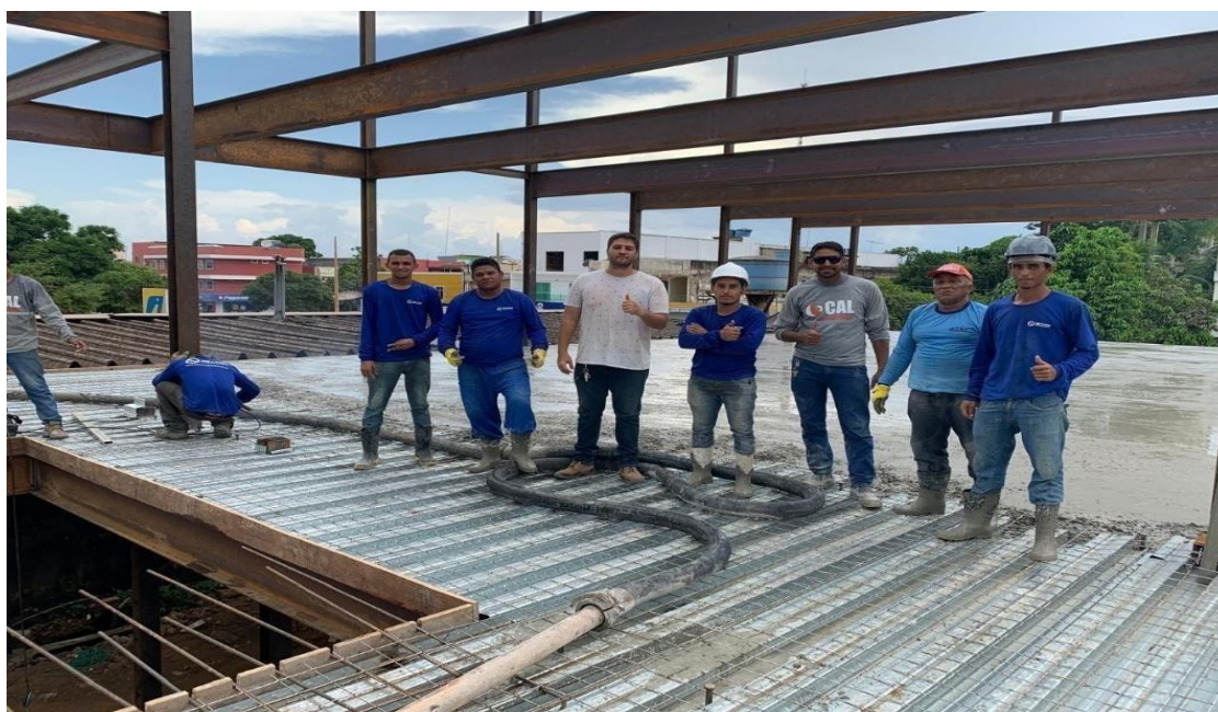
Figura 10: Coleta de dados durante etapa de execução da laje steel deck.
