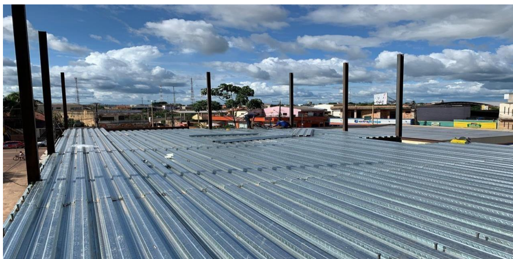
Figura 1: Vista superior parcial de uma estrutura steel deck.
