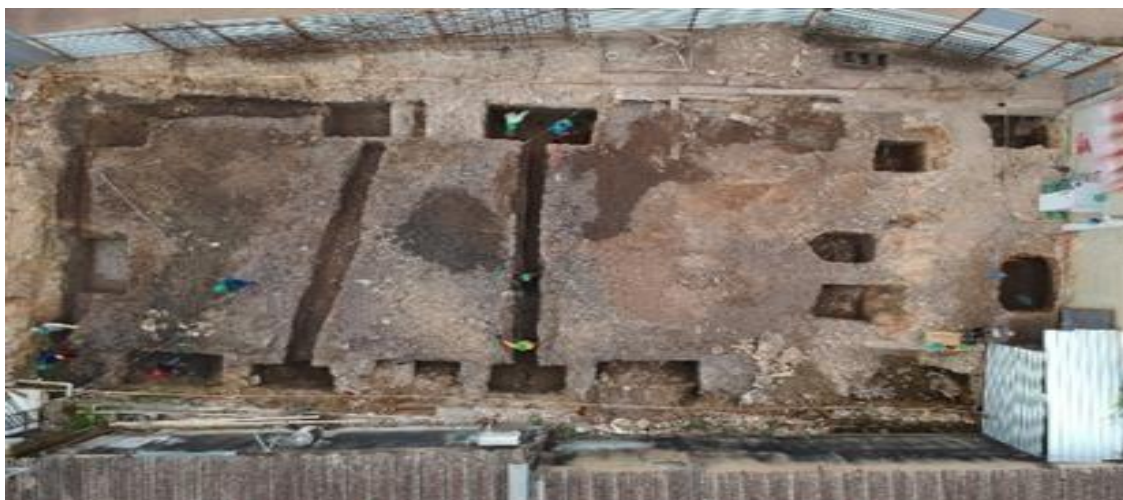
Figura 26: Execução da etapa da fundação.
