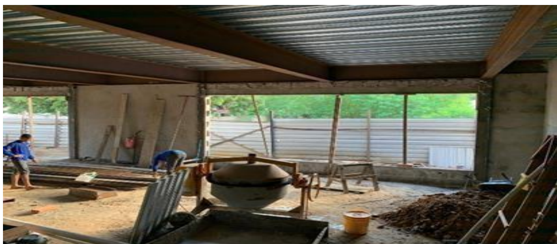
Figura 28: Execução da etapa da alvenaria.
