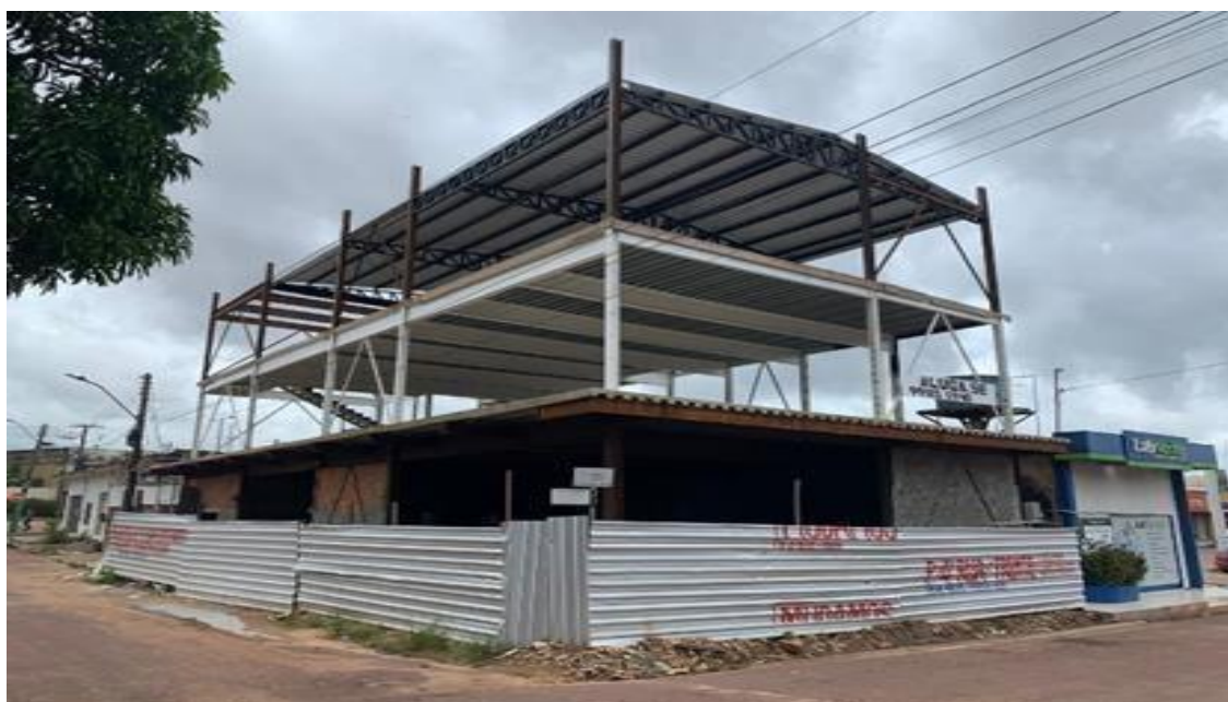
Figura 29: Execução da etapa da cobertura.
