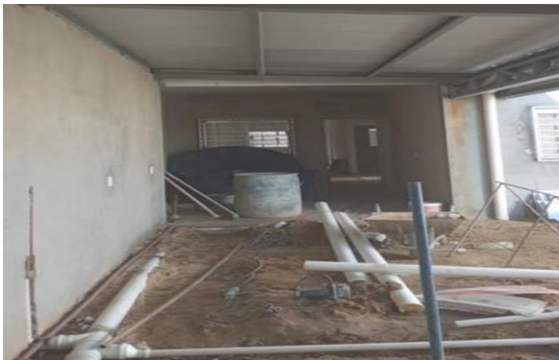
Figura 30: Execução da etapa da elétrica, hidráulica e hidrossanitário.
