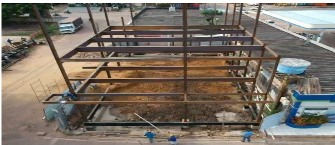
Figura 27: Execução da montagem da estrutura metálica.
