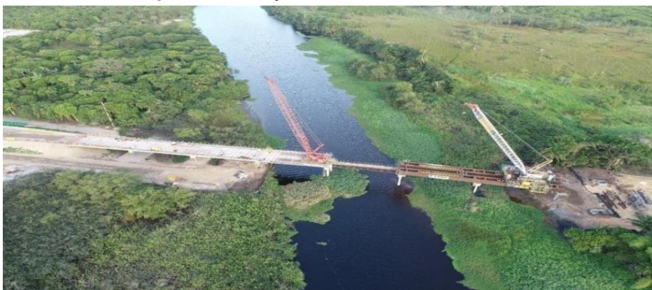
Figura 4: Construção da Ponte sobre o Rio Almada.
