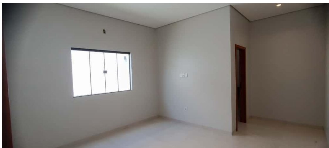
Figura 31: Execução da etapa de acabamento.
