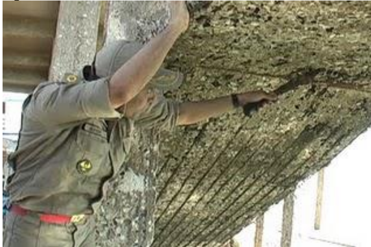
Imagem 7– Vistoria de bombeiro no terminal hidroviário municipal
