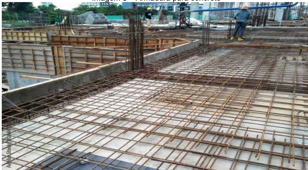
Imagem 5 – Armadura para concreto
