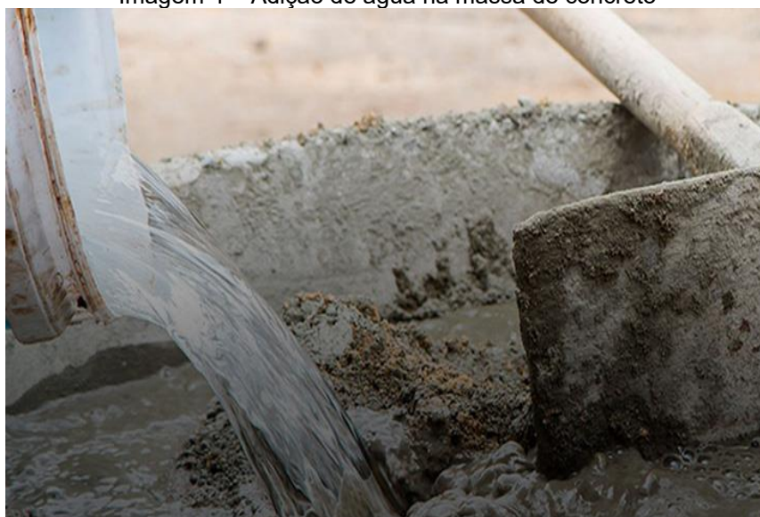
Imagem 4 – Adição de água na massa de concreto
