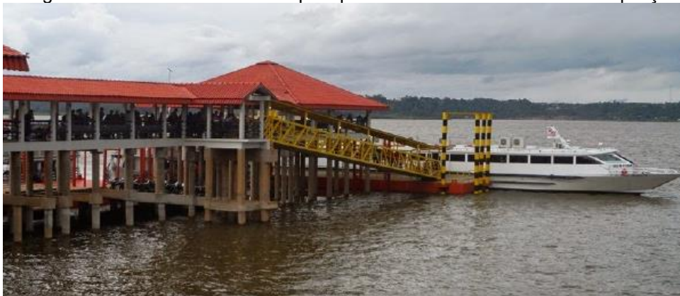
Imagem 9 – Plataforma de embarque após a conclusão da reforma e ampliação
