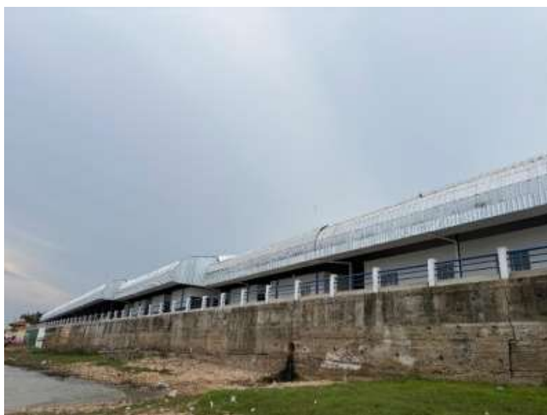
Figura 17 - Vista geral da Feira Beira Rio, com destaque para o muro de arrimo. Fonte: Próprio autor (2025).
