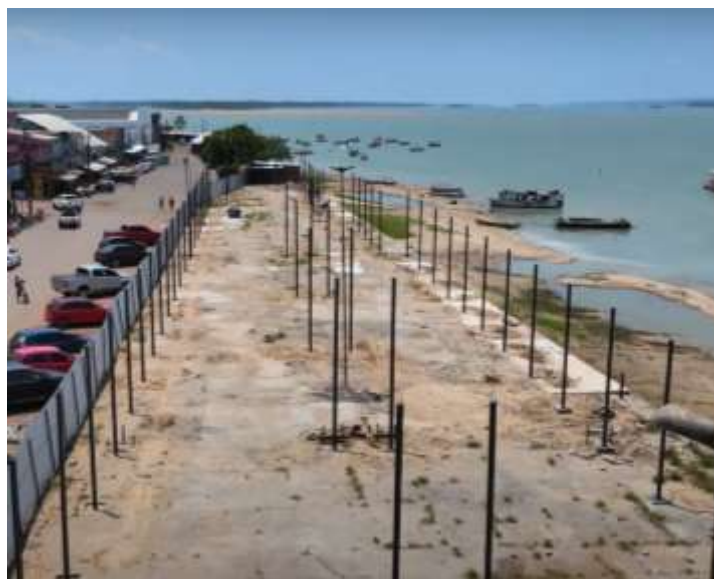
Figura 4 - Instalação da nova Estrutura em aço da Feira. Fonte: Portal Giro, 2023.
