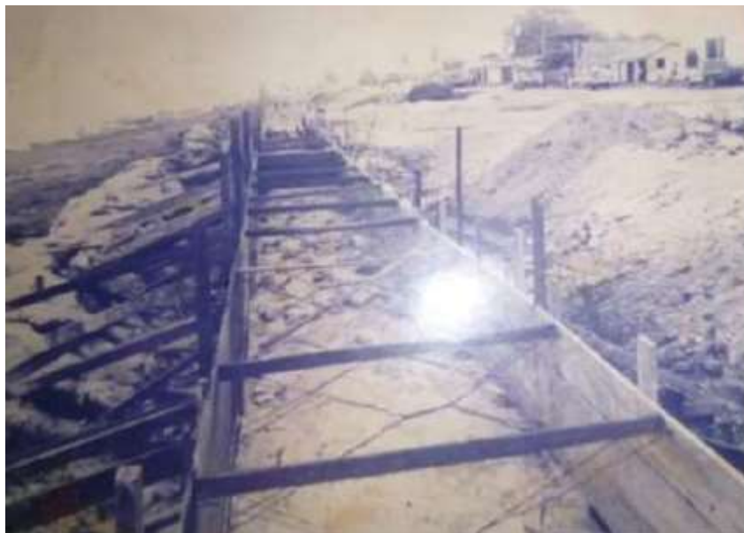
Figura 1 - Início da construção dos Cais de Itaituba em 1978. Fonte: Museu Aracy Paraguassú (2025).
