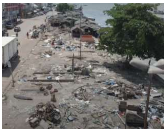
Figura 3 - Demolição da estrutura da antiga Feira Beira Rio. Fonte: Portal Giro, 2023.
