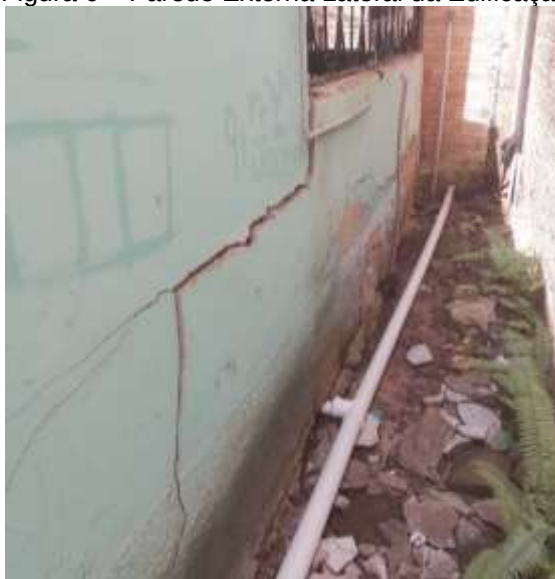
Figura 6 – Parede Externa Lateral da Edificação
