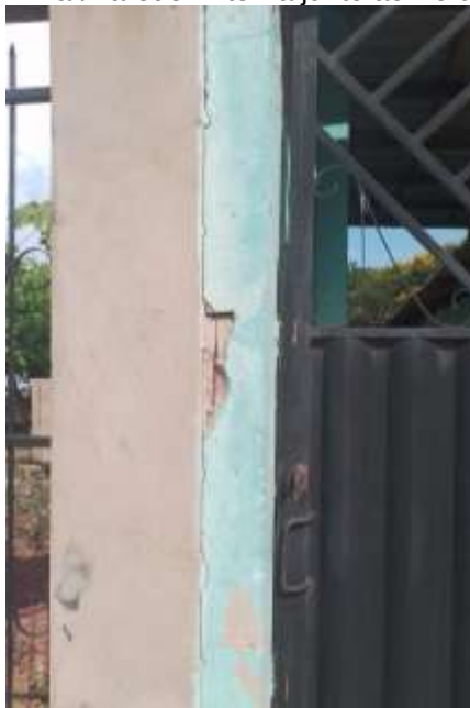
Figura 11 – Pilar/Parede Externa junto ao Portão Metálico
