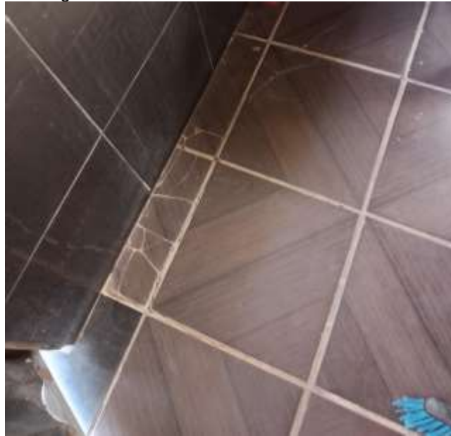
Figura 7 – Piso com Revestimento Cerâmico
