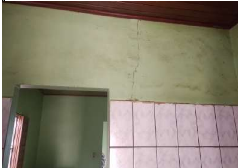
Figura 10 – Parede Interna Próxima ao Forro e Revestimento Cerâmico
