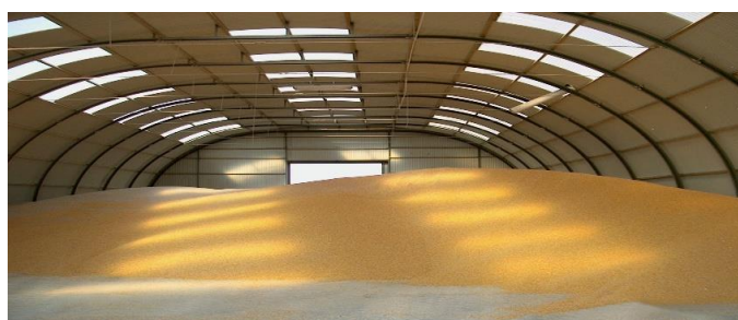
Figura 9- Exemplo de Silo Horizontal. Oliveira et al. (2022).
