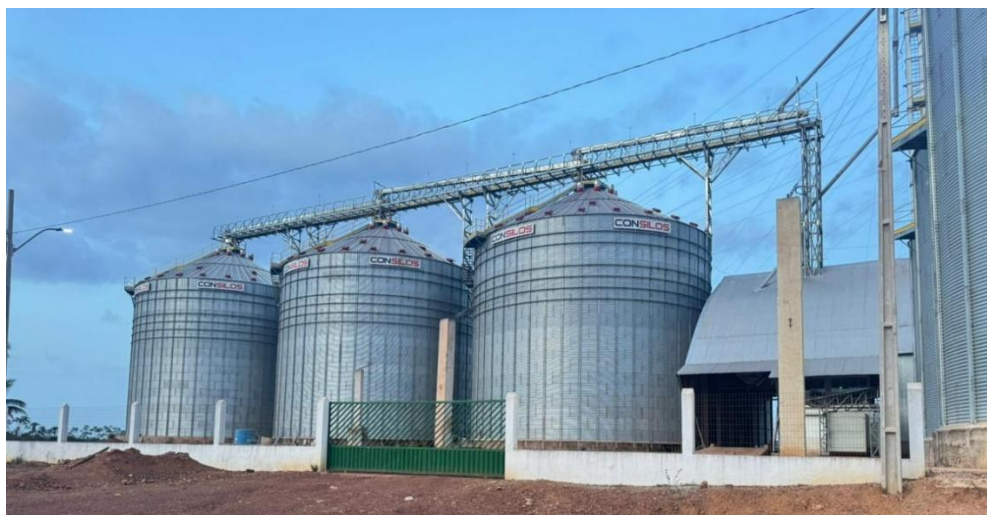
Figura 14- Silos com capacidade de 100 mil sacos. Fonte: Dados da pesquisa de campo (2026).
