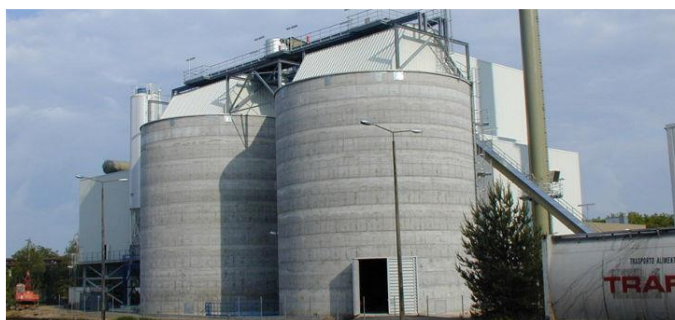
Figura 8– Exemplo de silo de concreto. Oliveira et al. (2022).
