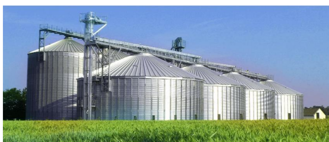
Figura 7- Exemplo de silo metálico. Oliveira et al. (2022).
