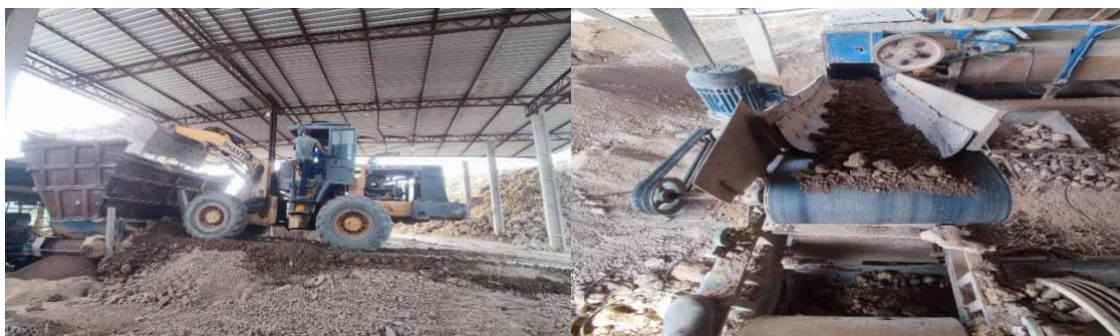
Figura 7 - Remoção da argila para o caixão alimentador. Fonte: dados da pesquisa (2023)
