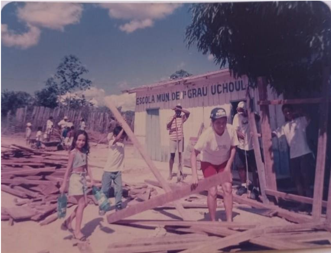
Construção da Escola Ieda Maria Gomes Barbalho (1989)
