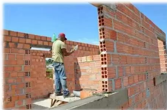
Figura 2 - Alvenaria Estrutural não-estrutural. Fonte: (MATCONSUPPLY, 2018)
