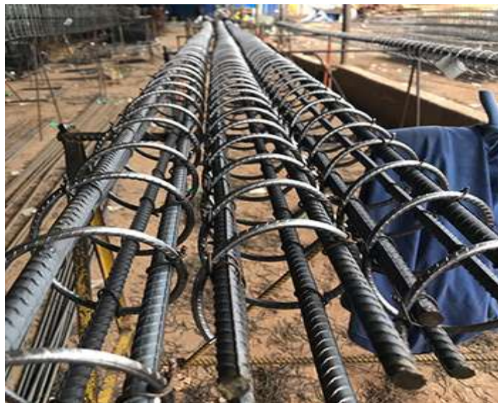
Figura 7- Estaca Hélice contínua- Fonte: Montaferro (2011)
