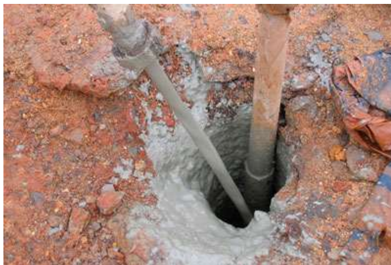
Figura 8- Injeção de calda de Cimento. Fonte: Solotrat (2021)
