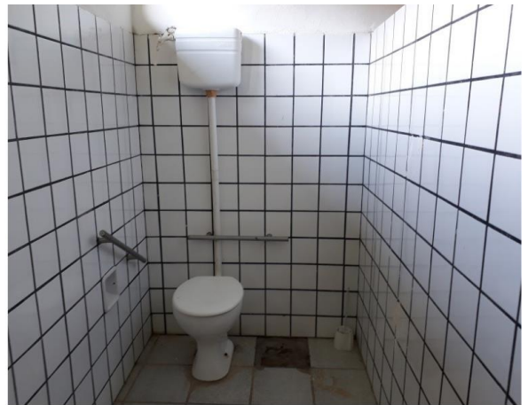
Banheiro adaptada da escola
