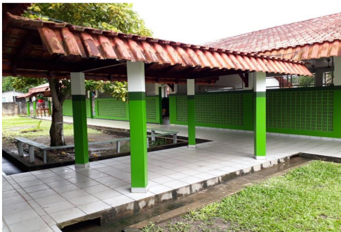
Entrada para o 3ª pavilhão da escola
