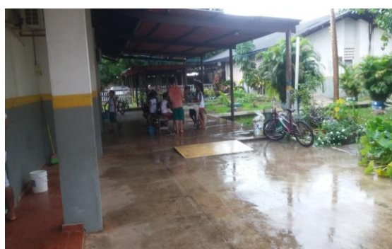
CRAS I – Refeitório
