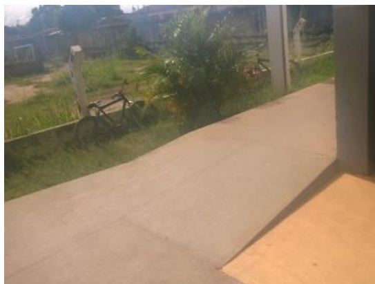
CRAS I – Rampa de Acessibilidade
