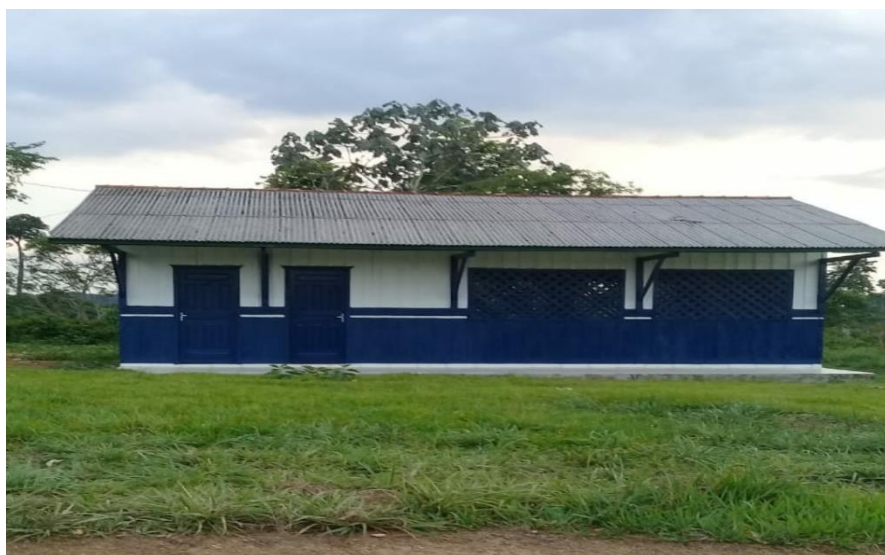
Figura 3. Fachada da Escola no ano de 2020.
