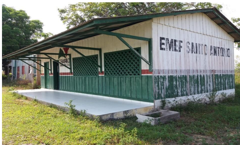
Figura 2. Fachada da Escola no ano de 2019.
