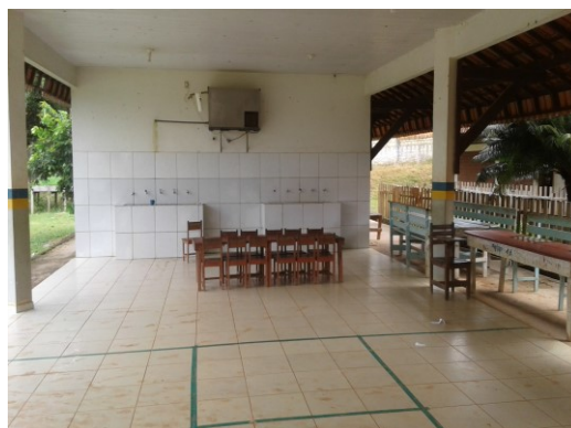
Pátio da escola e refeitório.
